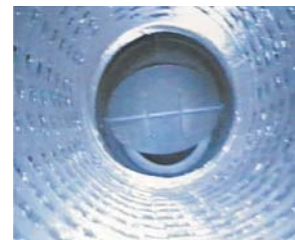
Le canal d'air après le nettoyage
